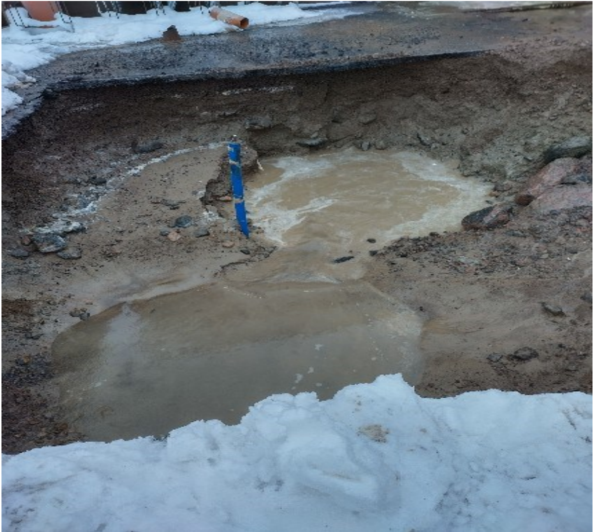
Savontie vesivuodon korjaus.
